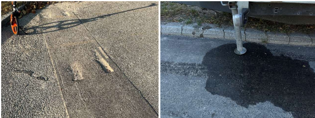
Figur 4.4.1 Indtryksmærker (tv) evt. årsag (th).
