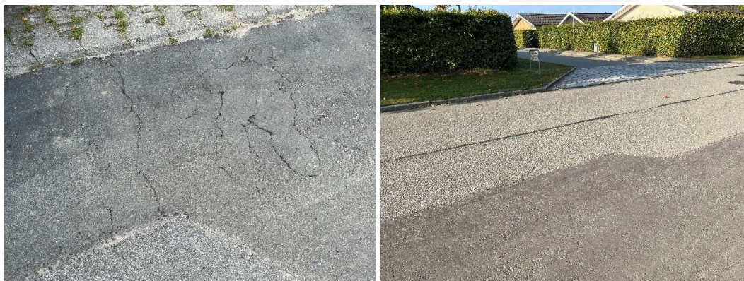
Figur 4.2.2 Overflade ledningsgrav genopfyldt med GAB 0.
