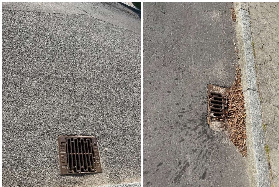
Fig. 4.6.1 Eksempler på afløbsriste: Regnersvej nr. 2-38 (th) samt nr. 40-140 (tv).
