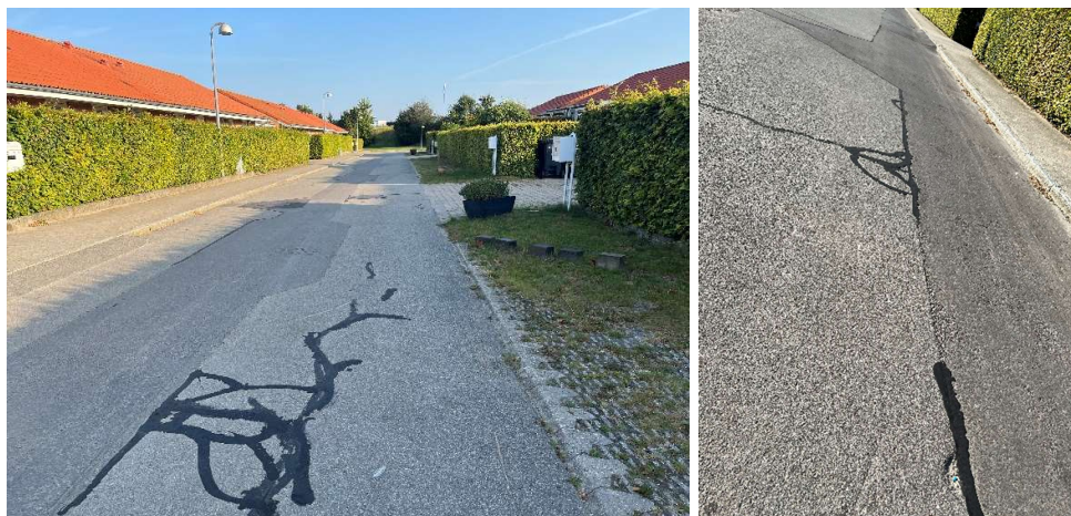
Figur 4.3.4 Eksempler på krakelering
